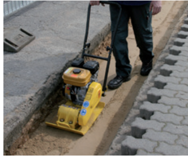
2. Einbringen der Sauberkeitsschicht Verdichten der Sauberkeitsschicht
