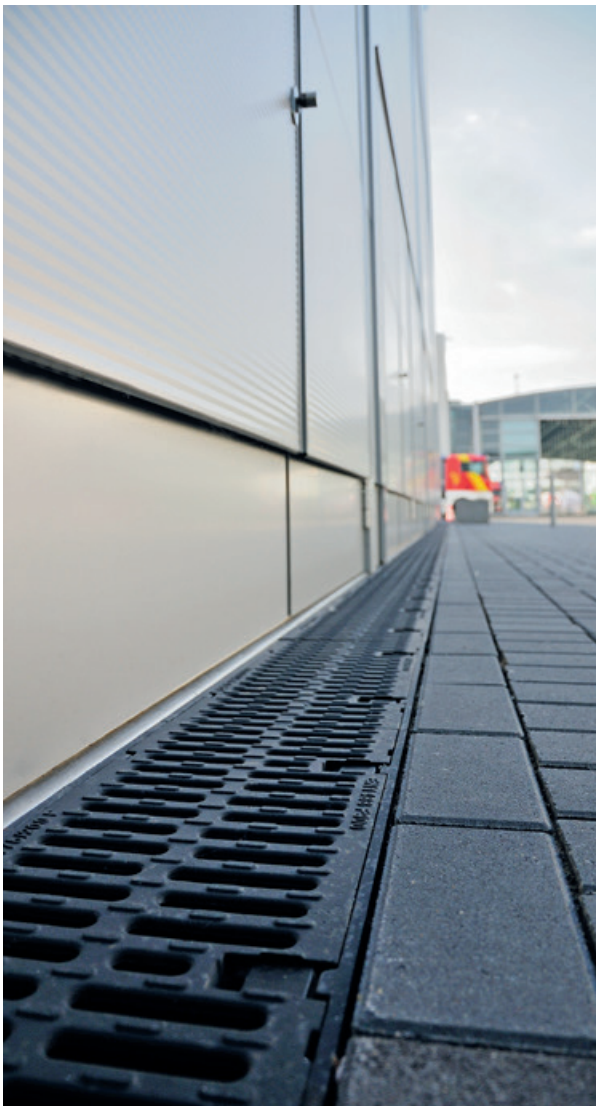
ACO PowerDrain im Außenbereich der Messe Hannover
