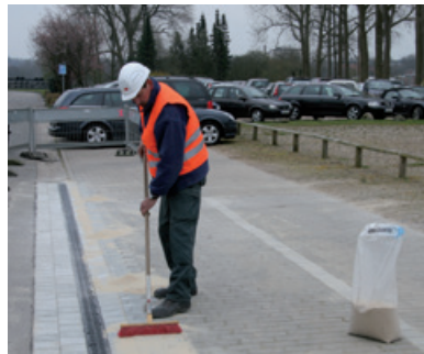
8. Verfüllen der Fugen mit Quarzsand
