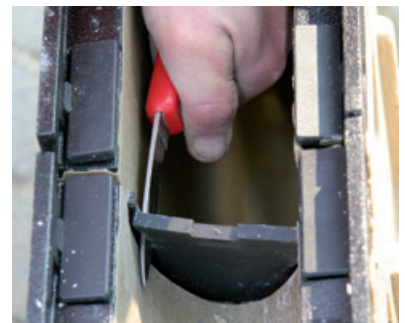
6. Ausschneiden der Anschlusschablone des Einlaufkastens
