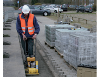
3. Einbringen des Fundamentes Verdichten des Fundamentes
