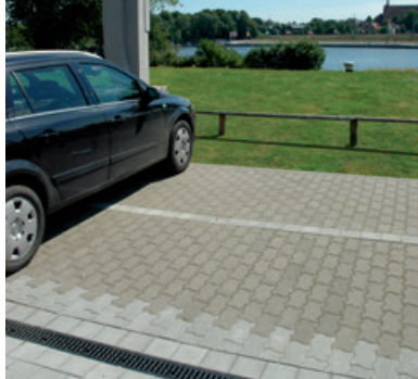
ACO PowerDrain als Parkplätzenwässerung
