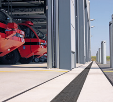
ACO PowerDrain in Zufahrten
